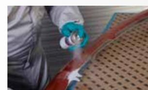
**3 шаг.** После этого поверхность обрабатывается Активатором адгезии 3M™ 05917. Время выдержки должно составлять 10 минут.
